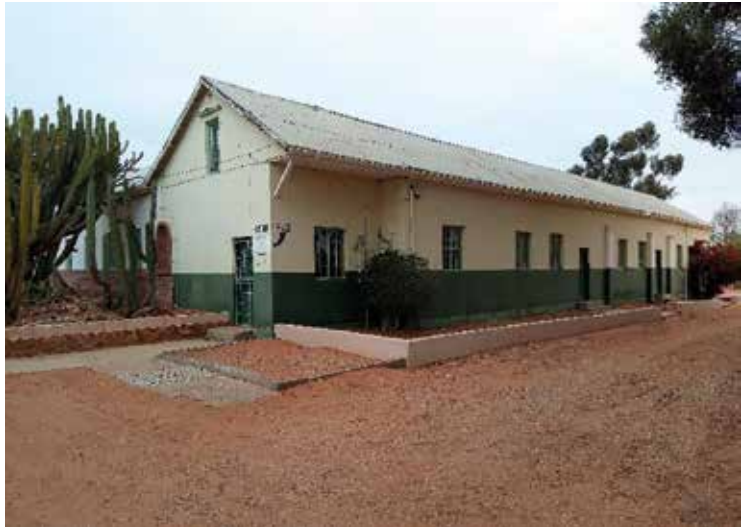
Das alte Schulhaus auf dem Gelände der Vergenhoeg-Farm
